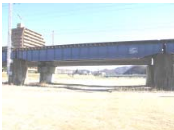
写真2 試験施工完了状況
