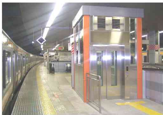
写真 - 2 ホーム上の設置状況(東京駅)
