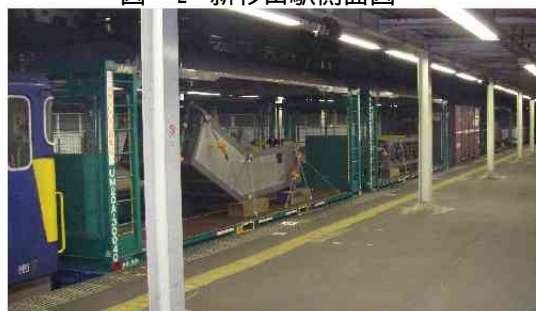
写真 - 1 貨車搬入状況(新杉田駅)
