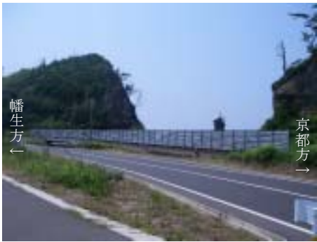
図-5 防風柵施工後
