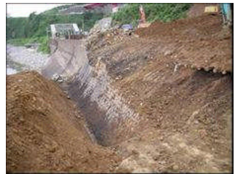
写真 3 護岸擁壁の損傷状況
