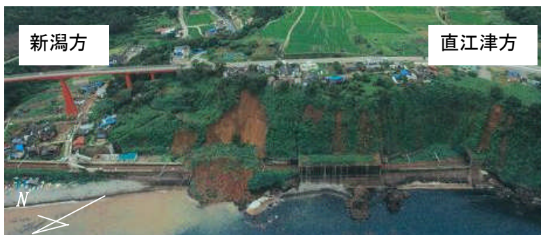
写真1 斜面崩壊箇所の斜め写真
