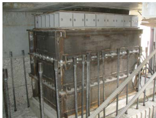
図2. 仮支承部状況
