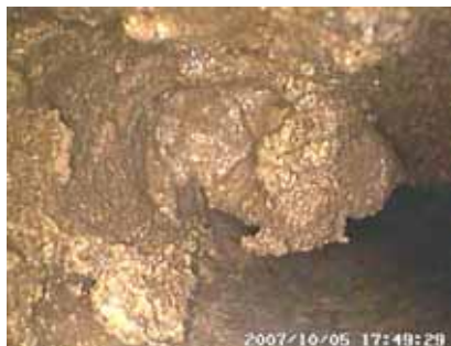
写真-2 水抜き孔内状況
