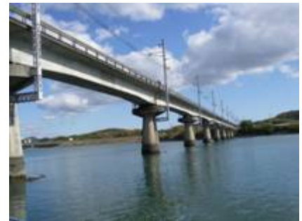
図-2 当該橋りょう全景
