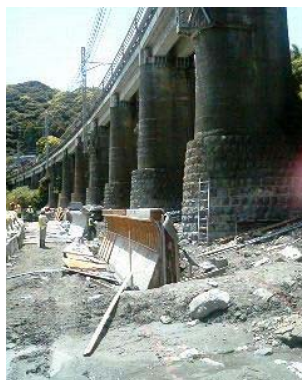
写真-2 施工状況
