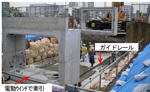
写真-1 ボックスカルバート吊込み・牽引状況
