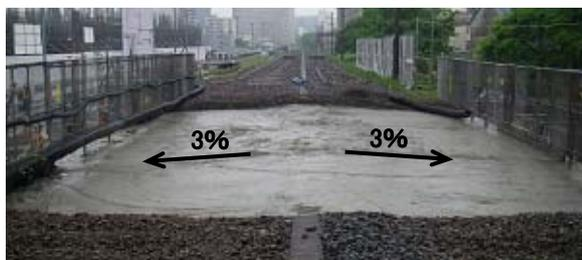
写真-3 流動化処理土打設後状況
