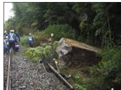
図 2 線路際に落下した巨岩
