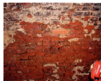
写-4 レンガ覆工状態
