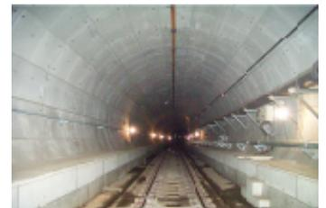
写真2 二次覆工施工後
