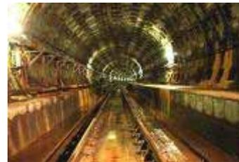
写真1 二次覆工施工前
