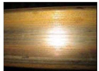
図-11 ミリングによる削正痕
