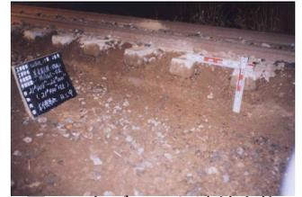
図8 鼻バラスト連続交換による噴泥除去作業
