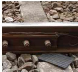
図6 ハック継目部の軌道パット飛び出し
