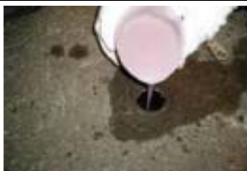
図-4 注入孔より材料を注入
