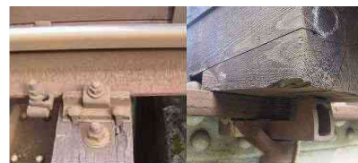
写真 - 2 既設 タイプレートとフックボルト
