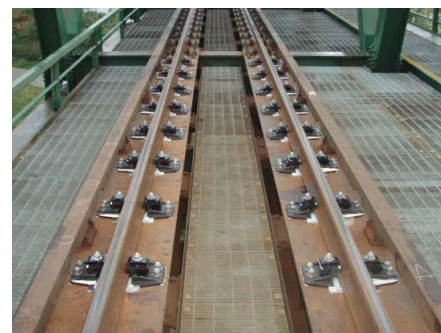
図5 現地敷設試験の状況
