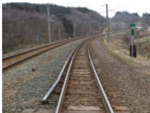
写真-2 安全ガードへの置き換え箇所
