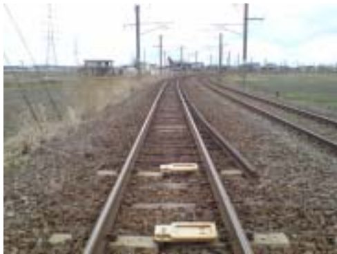
写真-1 安全レール敷設箇所
