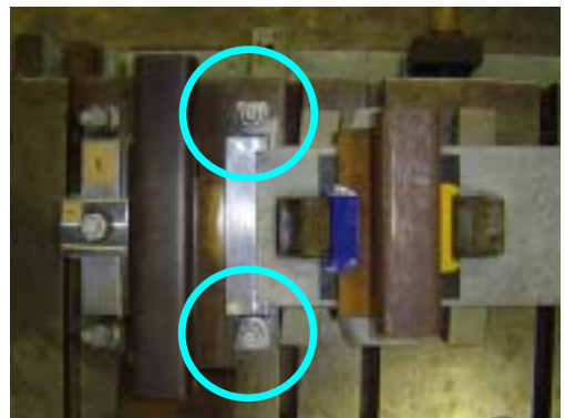
写真-6 支障するボルト
