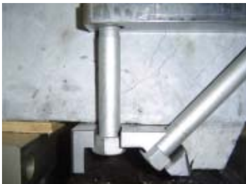
写真-4 急曲線用P Cまくらぎのクラック
