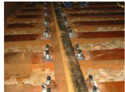
写真－2：敷設状況
