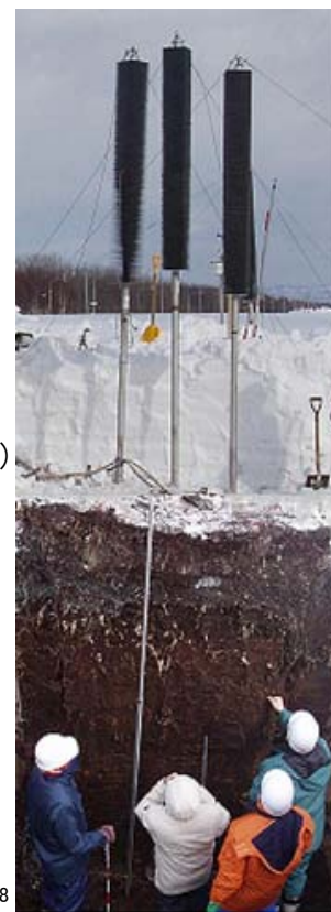
写真1 HP と凍土壁外面
