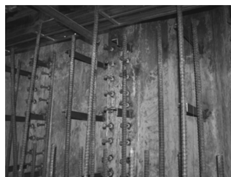
図5 スタッド溶接後の状況
