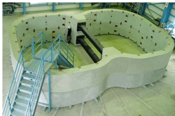
写真－1 セグメント仮組状況
