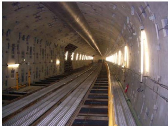
写真-1 施工完了状況
