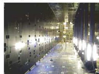
写真-2 施工完了時内面
