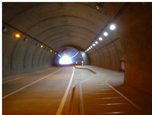
写真－1 三豊トンネル避難スペース
