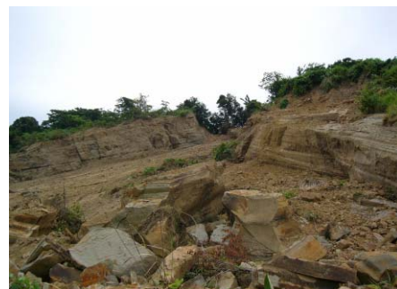
写真-2 第一米山トンネル (トンネル上方斜面崩壊状況)
