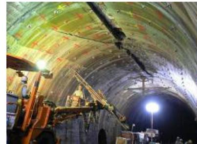
写真-2 ロックボルト打設状況
