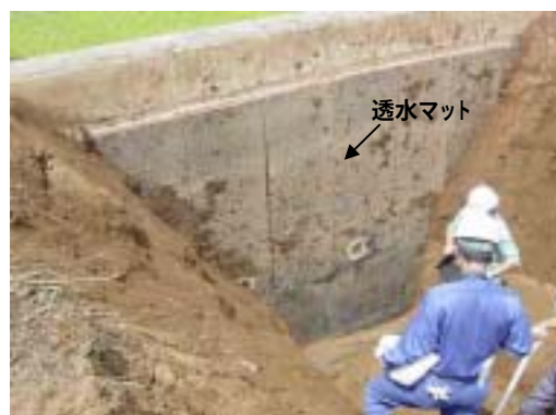
図-3 透水マットの掘り起こし状況
