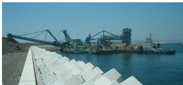
写真-1 揚土船による埋立土砂の 2 次揚土
