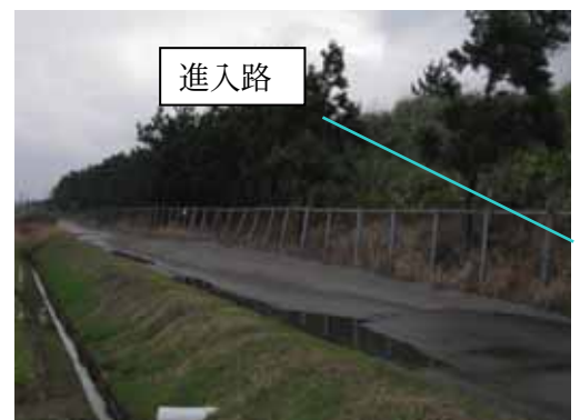
写真-1 被害状況
