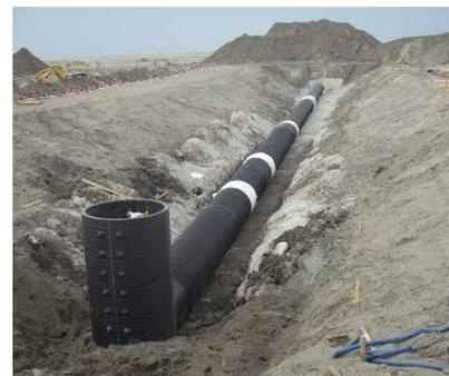
写真-1 埋設管設置
