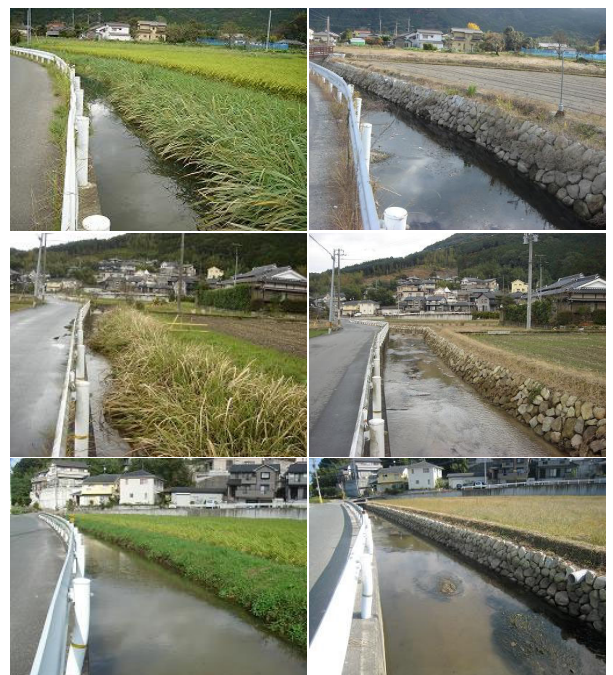
写真 1 護岸改修前と後の様子
