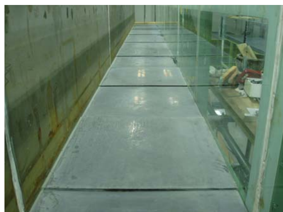
写真-2 パネル設置状況
