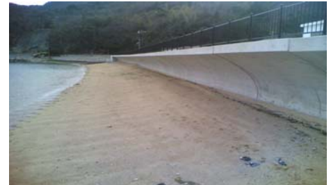
写真-1 現地施工されたフレア型護岸
