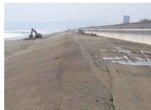
写真-1 養浜盛土の施工状況
