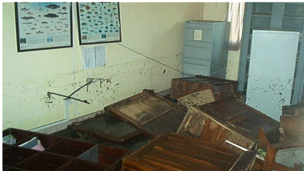
写真-2 津波被害状況（構造物被害レベル 1）
