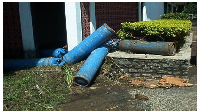
写真-5 津波被害状況（設備被害レベル 2）
