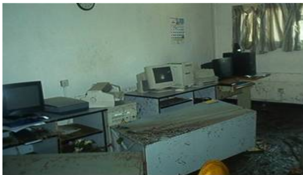
写真-4 津波被害状況（設備被害レベル 1）
