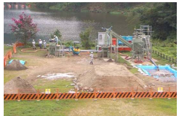
写真-1 堆砂処理システムの現地設置状況
