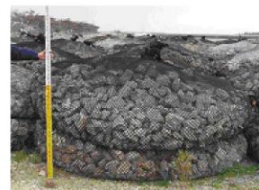
写真 2 低天端堤に用いた袋型ユニット
