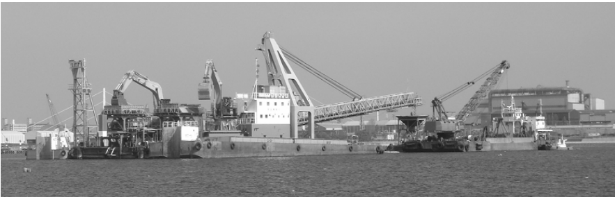
図-1 混合・投入部と施工状況
