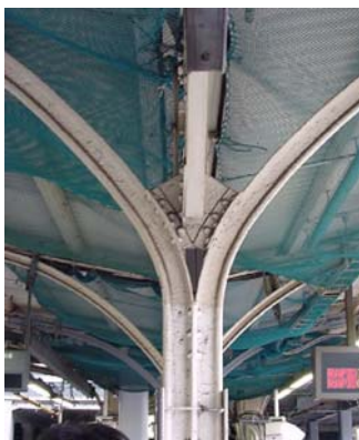
写真-2 田端駅ホーム上屋支柱
