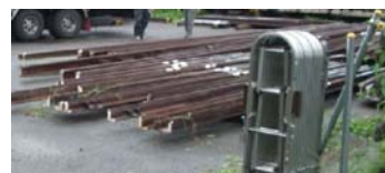
写真-4 雀宮構内保管レール
