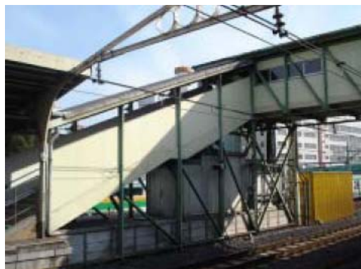
写真-1 古レール造乗換え跨線橋例
