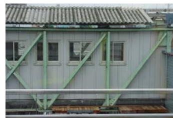
写真-3 松本駅跨線橋部
