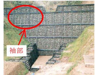
写真-1 鋼製枠砂防堰堤
