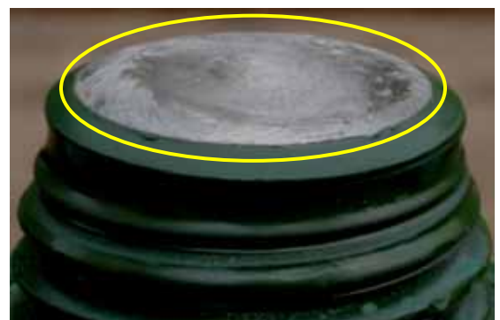
写真-7 仕上げ後のピンテール破断跡
