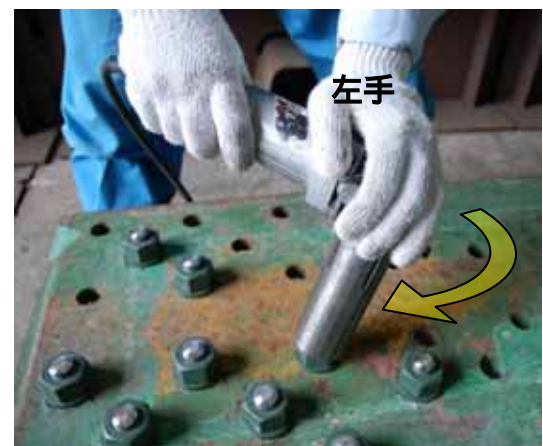
写真-5 仕上げ作業
