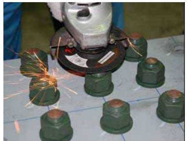
写真 - 2 ディスクグラインダーによる仕上げ作業
