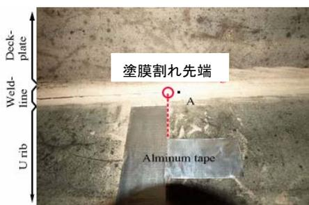
図 6 防食塗装膜下のき裂検出
