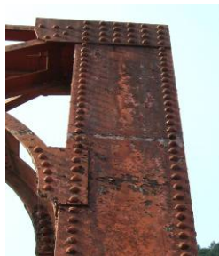
写真 1 塗装の劣化
