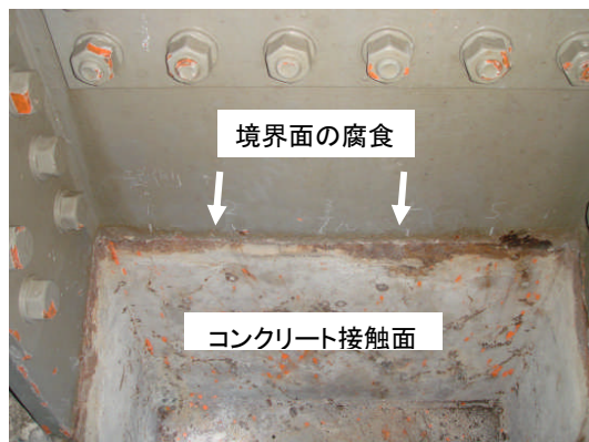
写真 5 斜材コンクリート床版接触面状況
