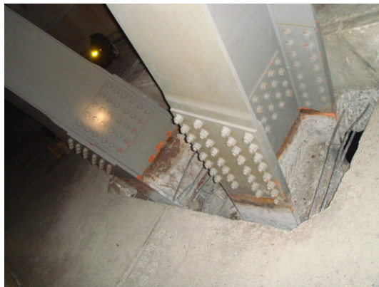
写真 4 斜材固定スラブ撤去状況
