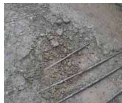
写真-2 床版上面の砂利化
