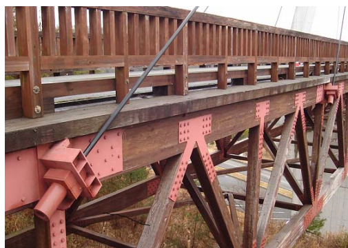
写真-2 用倉大橋の部材
