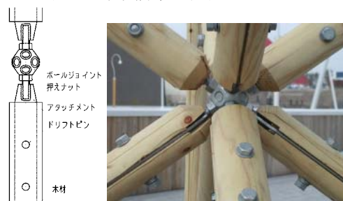
図-2 トラスシステム接合部構成
