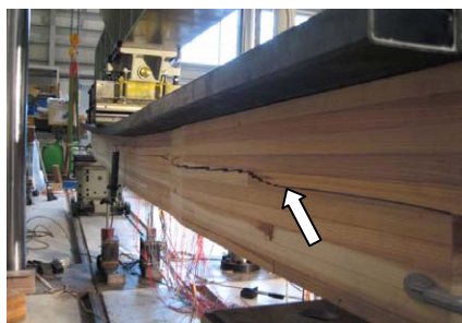
写真2 せん断破壊状況
