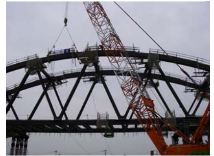
写真-2 閉合作業状況
